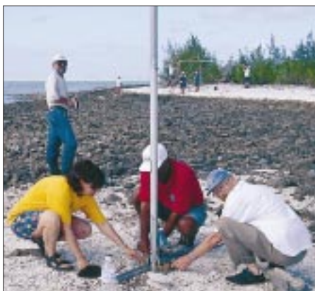
Christine, Urs, Jacky und Hugo befestigen die Radialdrähte an der Battie Creek Special.
